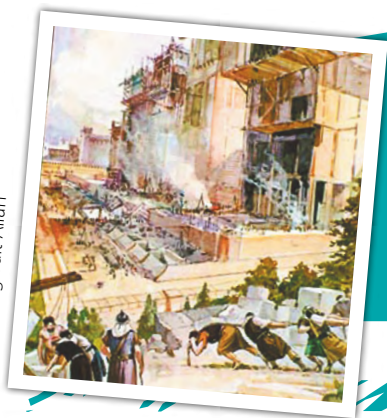
Gedung Bait Allah
